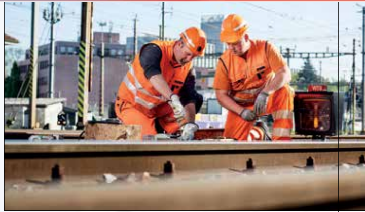
▲ SBB Infrastruktur sorgt für ein gut funktionierendes Schienennetz
